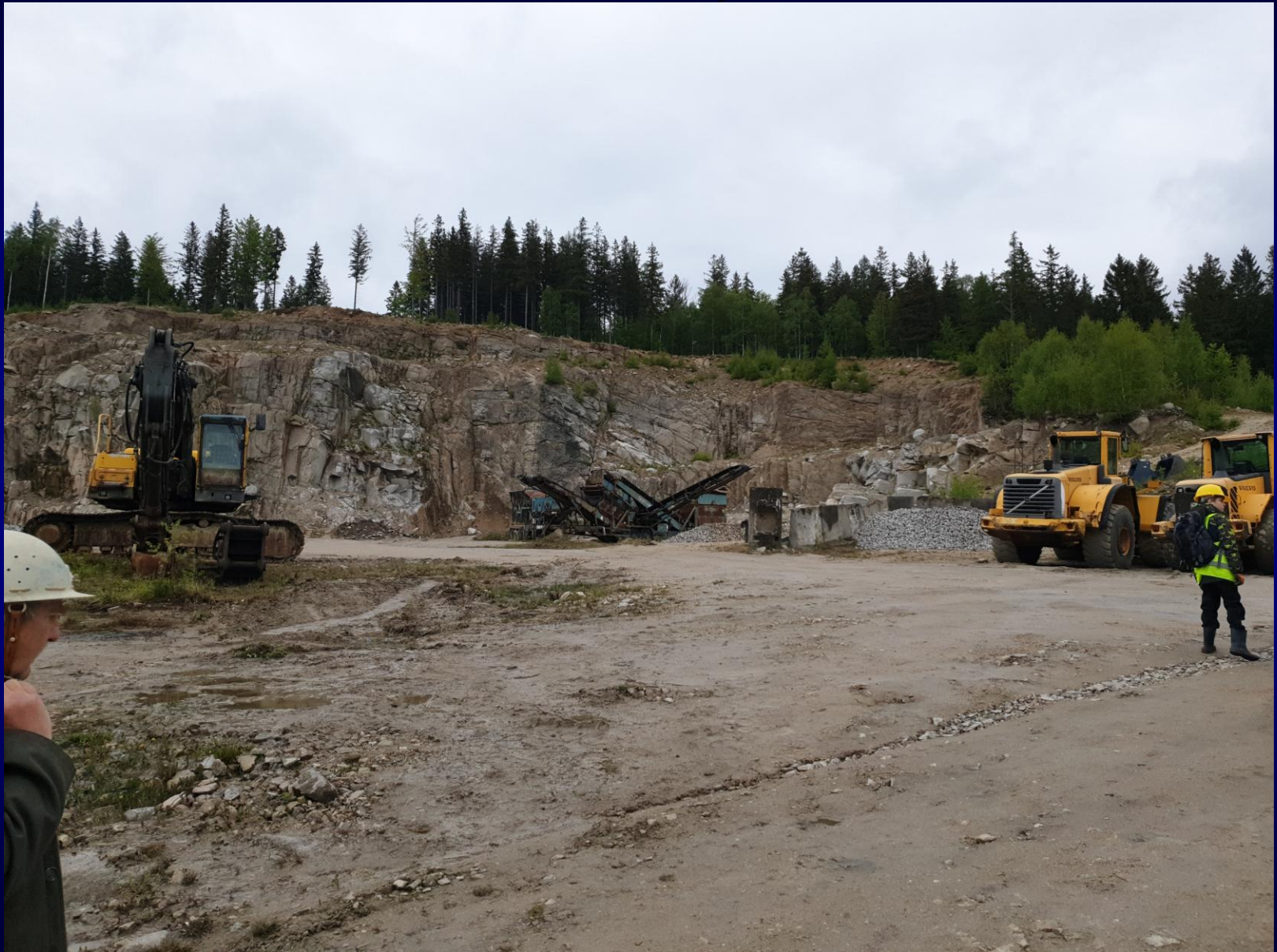
Celkový pohled na lom
