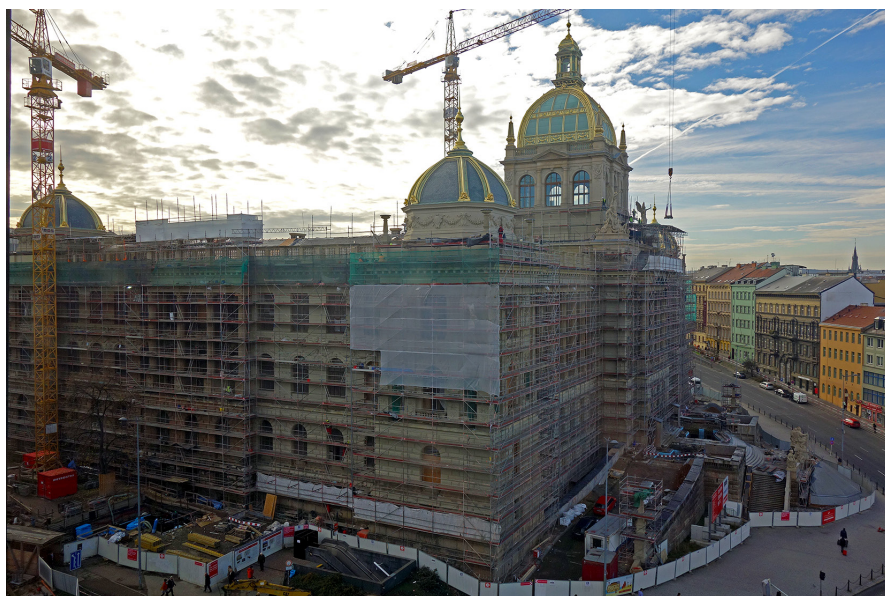
Rekonstrukce budovy Národního muzea v prosinci 2017 (pohled z 5. patra Nové budovy NM)
